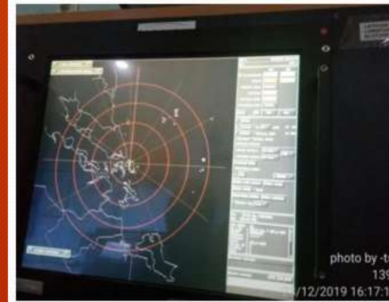
Perbaikan radar di satrad 213 Tahun 2019
